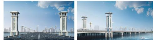
立交改造为蝶形全互通立交，匝道布设在充分考虑防洪的基础上减少占地，优化交通组织，以达到主路快速通行的目的，立交范围内机非分离，人非道路结合右转匝道布置在立交外侧，通过设置人非下穿通道、人形梯道来实现人非交通的互通。北京路沂河特大桥主线设计车速60km/h，匝道设计车速30km/h，防洪标准为百年一遇。桥梁采用10车道+非机动车道。人行道的建设规模，在老桥两侧对称新建15米的拼宽桥，桥面总宽52米。老桥保留利用，上部结构整体顶升2米，以满足防洪要求。新建拼宽桥采用60米跨径的变高度连续梁。
